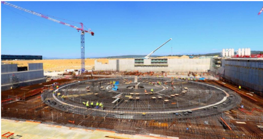
Figure : Exemple de structure : le supportage de la machine Tokamak
