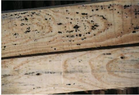
FIG. 1.4 – Bleuissement sur charpente
