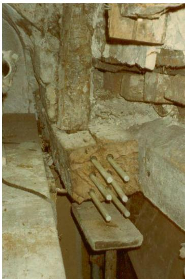
FIG. 1.7 – Exemple de restauration par goujons collés (photo BEPOX)
