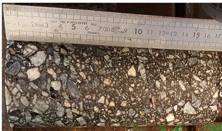
FIGURE 1.10: Carotte d'enrobé bitumineux
