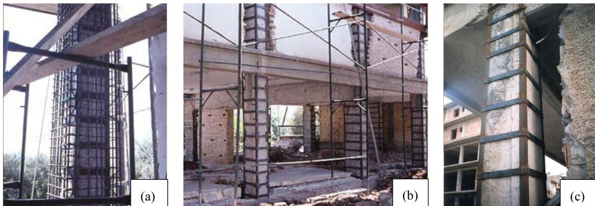
Figure 1-16: Chemisage en acier appliqué aux poteaux
