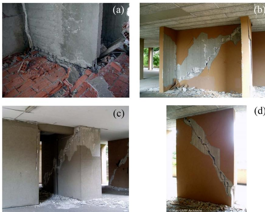
**Figure 1-7: Dommages subis par les voiles (a) Rupture de section à la base du voile (Séisme de Boumerdes du 21/05/2003) ; (b-d) : Rupture en cisaillement des voiles (Séisme de L'Aquila 06/04/2009)**
