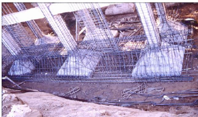
Figure 1-21: Fondation renforcée par chemisage RC (Fardis 2009)
