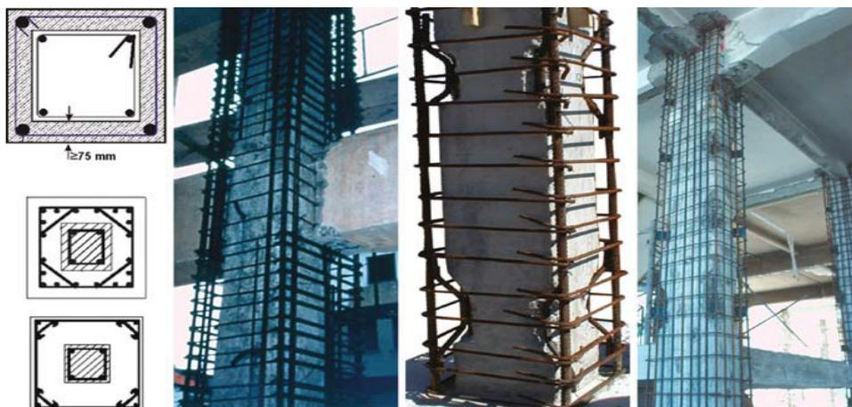
Figure 1-13: Chemisage en béton pour augmenter la section de poteau ([Fardis 2009](#))
