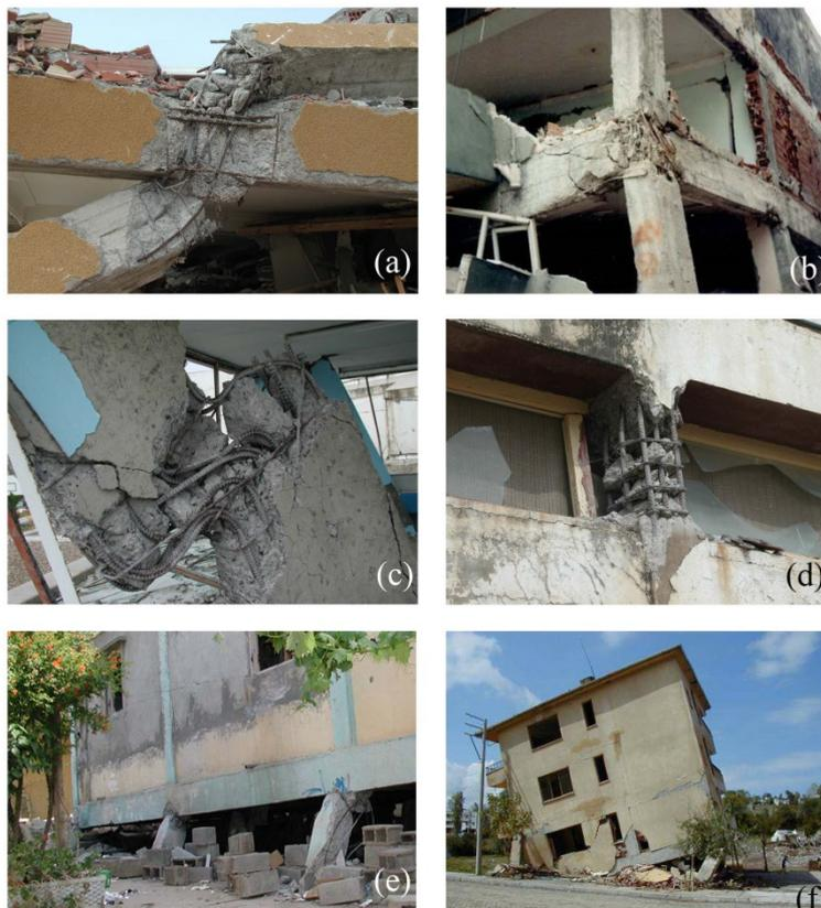
Figure 1-4: Dommages subis par les portiques (a) : Rupture en zone de noeud d'ossature (b) : Rupture dans un poteau (c) Rupture de cisaillement dans un poteau (d-e) Rupture des poteaux courts ([Séisme de Boumerdes du 21/05/2003](#)) (f) : Effondrement du 1<sup>er</sup> niveau (Séismes de Bhuj 2001, Inde)
