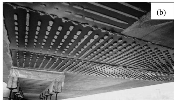
Figure 1-15: Plaque métallique collée (a) difficulté de manutention ; (b) Renforcement du viaduc de Terrenoire par tôles collées perforées -Brevet Freyssinet- ([Luyckx 1999](#))
