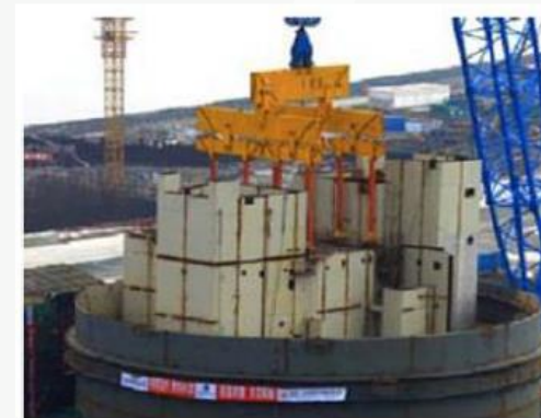
Module de confinement du réacteur AP1000 (Lohani, 2016)
