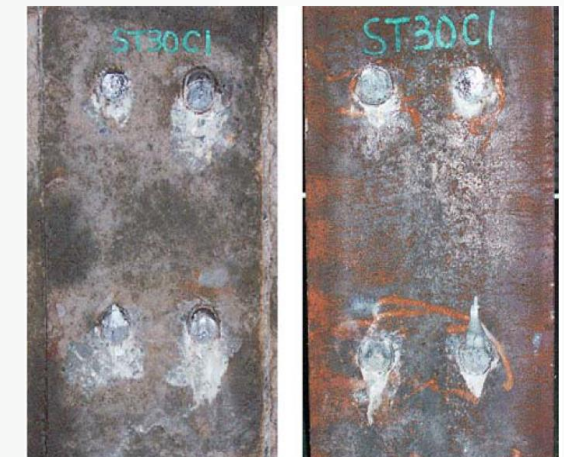
Faciès de ruine par rupture en cisaillement des tiges des goujons (Shim, et al., 2004)
