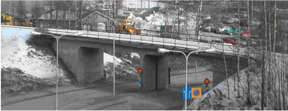
FIG. 4.64 – Vue globale du pont d'Örnsköldsvik.
