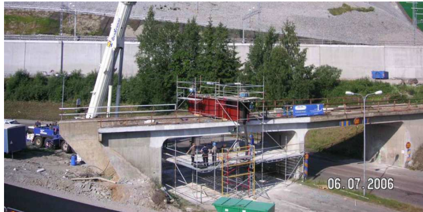
FIG. 4.66 – Montage de chargement du pont d'Örnköldsvik.
